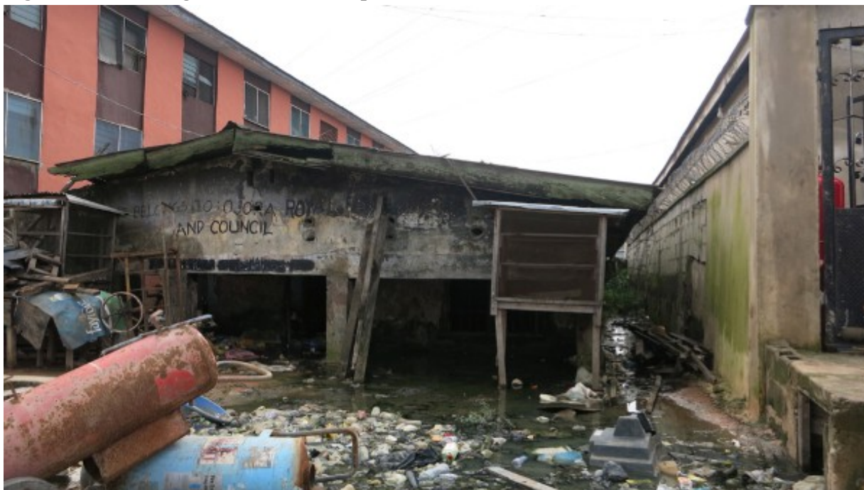
Figure 4. Une sinking house – « maison qui coule » – dans Amukoko
