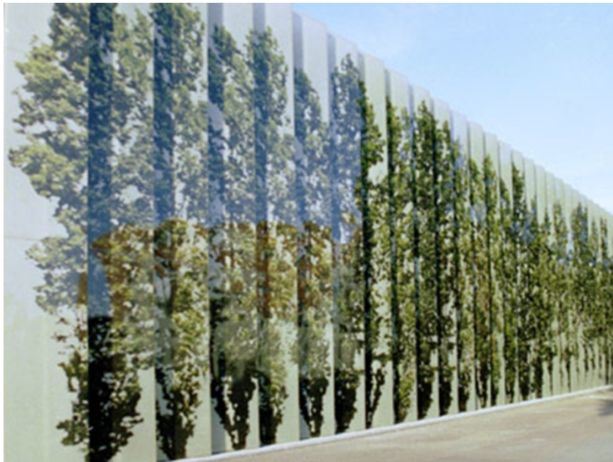
Bibliothèque de l'École nationale supérieure d'architecture et de paysage (ENSAP) de Bordeaux. Habillage de la façade via une technique d'impression numérique en encres UV sur des panneaux translucides en matériaux composites. © S. Wachter.
